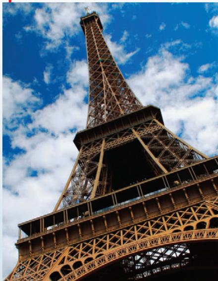
Ogni sette anni, la Torre Eiffel, costruita nel 1889 e costituita di ferro con una bassa percentuale di carbonio, viene completamente riverniciata per evitare la formazione di ruggine.
