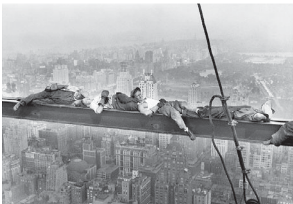
Costruire in altezza pone da sempre problemi di sicurezza.
